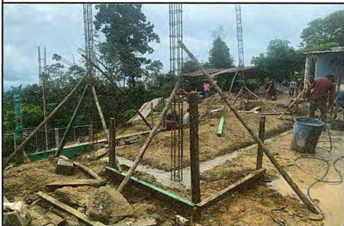
Foto 3: Inicio de remozamiento del área de cocina.
