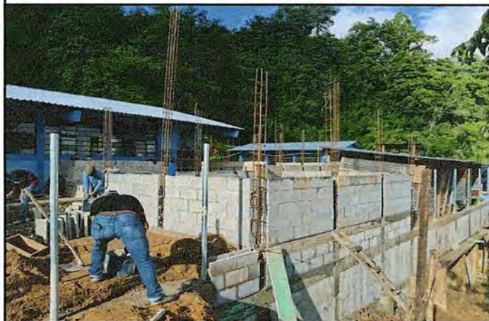
Foto 4: Avance de remozamiento de cocina e inicio de colocación de tubos para circular, parte frontal.
